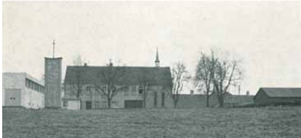
Das Schwesternwohnheim mit der nicht nutzbaren Kapelle und links im Vordergrund die notdürftig erbaute Baracke.
