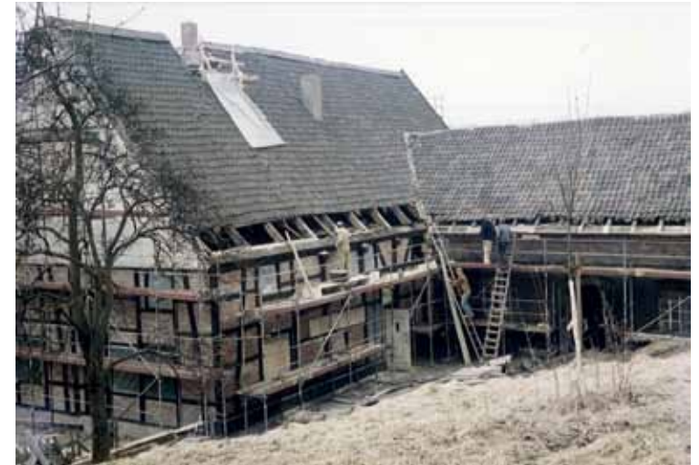
Bauarbeiten an Haupthaus und Kubstall des Hofes Beckmann.
