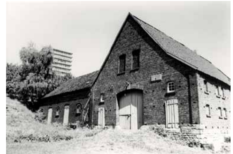
Das Haupthaus des Hofes Beckmann (Westansicht) im Jahr 1973, links ein Anbau, der in früherer Zeit als Kuhstall genutzt wurde. Das Tor am Haupthaus führte auf die Tenne. Im Hintergrund ist eines der 13-stöckigen Institutsgebäude der Universität zu erkennen.
