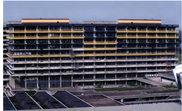
Abb. 8: Ostfassade des Gebäudes GA während des Anstrichs am 28. Mai 1985
