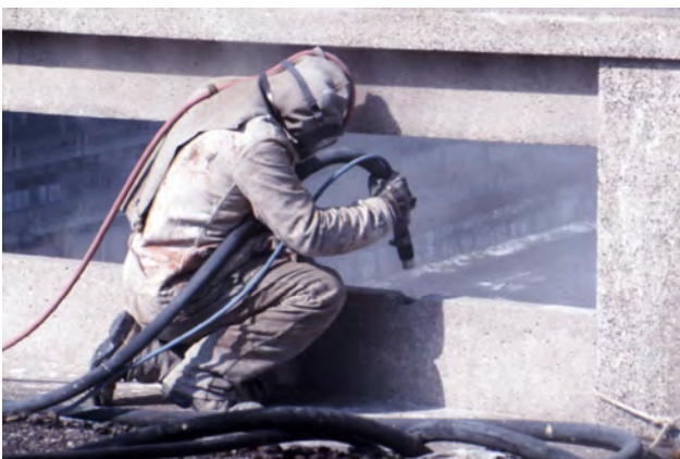
Abb. 4: Sandstrahlung der Dachebene am Gebäude GA, März 1985
