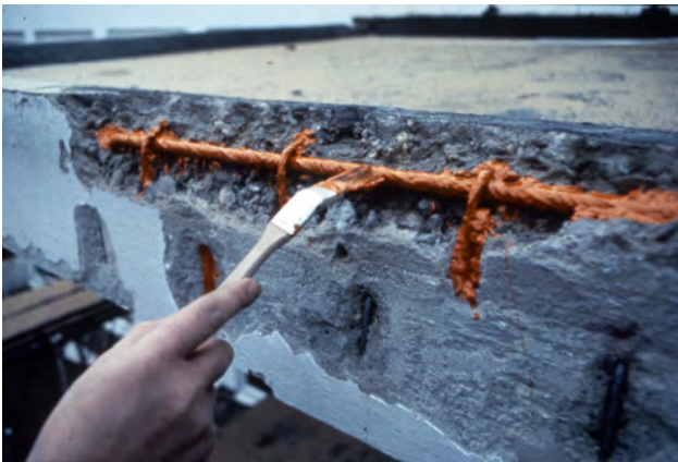
Abb. 5: Behandlung der freigelegten Bewehrung mit Epoxidharz
