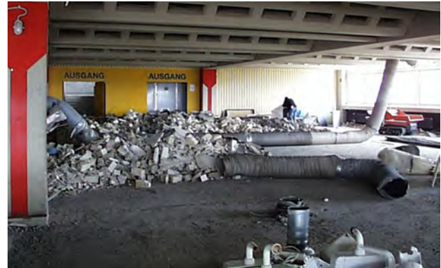
Abb. 19: Beginn der Sanierungsarbeiten mit Abbruch
