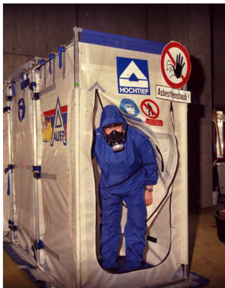
Abb. 15: Sicherheitsvorkehrungen: Asbestentsorgung nur mit Schutzkleidung und hinter Schleusen
