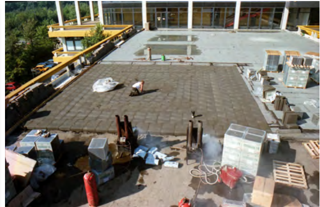
Abb. 9: Verlegung einer Wärmedämmung aus Foamglas in Heißbitumen bei GB (1983), im Hintergrund die bereits aufgetragene zweilagige bituminöse Abdichtung
