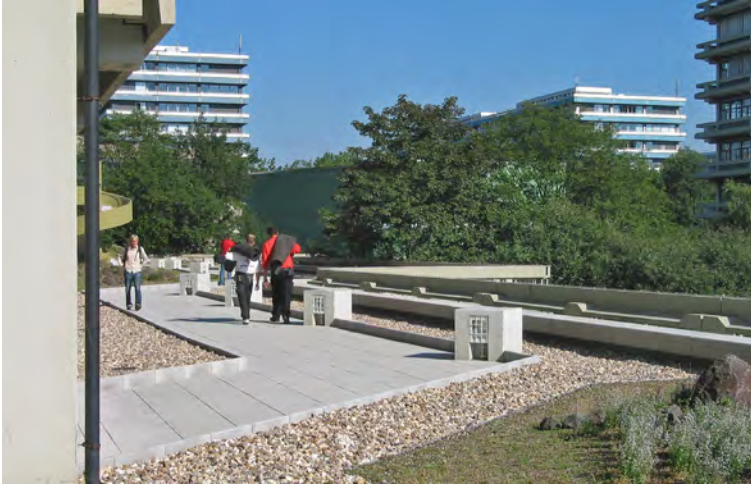
Abb. 12: Neue Wegegestaltung auf den sanierten Dächern der Flachbereiche der N-Reihe
